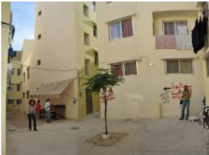
Wiederaufbau des Flüchtlingslagers Nahr el-Bared in Tripoli im Libanon (Bild: akdn.org)
