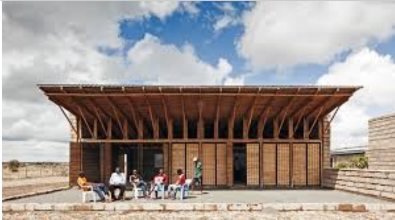
Handwerkerschule in Malaa bei Nairobi, Kenia (Bild: Matthias Kestel © Fachgebiet Holzbau der TU München)
