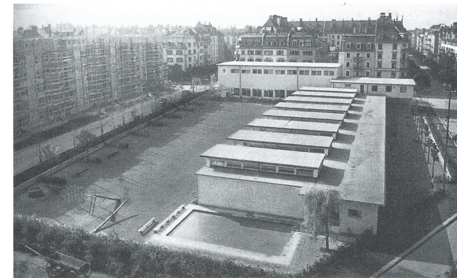
Kindergarten in Zürich-Wiedikon, 1932. Architekten: Hans Hofmann und Adolf Kellermüller
